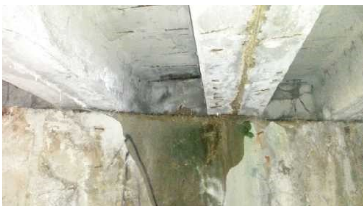
Zatékání na úložný práh OP2
