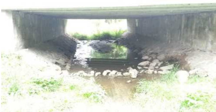
Podhled NK z návodní strany, koryto zanesené naplaveninami a lomovým kamenem uvolněným z opevnění opěr.
