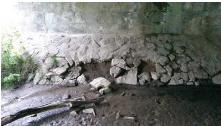
Uvolněné a poškozené opevnění OP2
