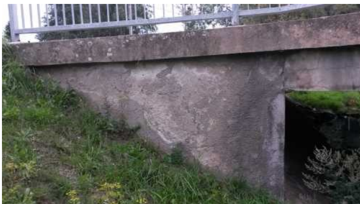
Pohled na levé křídlo OP2 - degradace povrchu betonu
