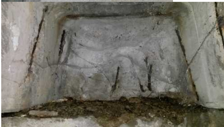
Zanesený úložný práh, odhalená výztuž a její koroze
