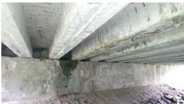
Pohled na OP2, stopy po zatékání, zelené výkvěty.
